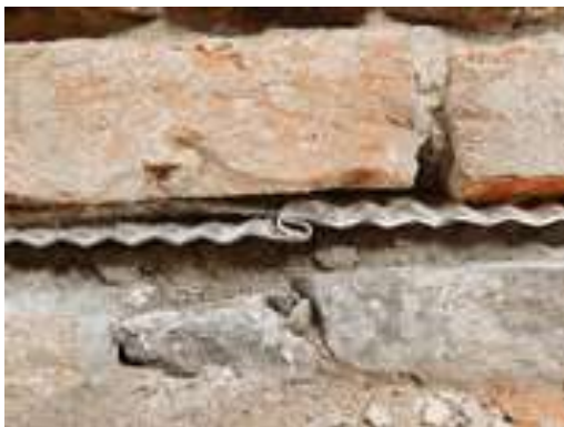
Obr. 6.1 Vkládání chrom-niklových desek do cihelného zdiva
