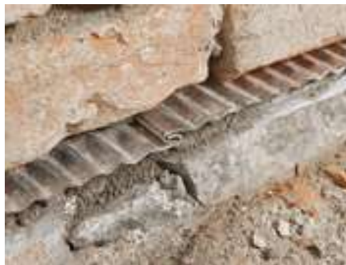
Obr. 6.1 Vkládání chrom-niklových desek do cihelného zdiva
